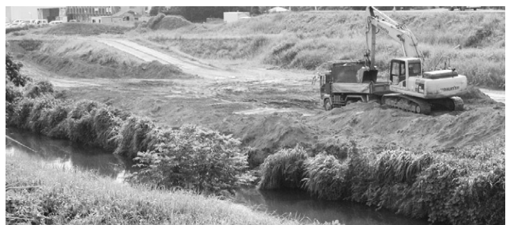
鎌田川改修工事
