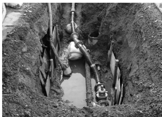
石綿管布設替工事
