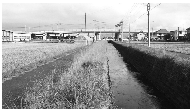
清川排水路 布施地区
