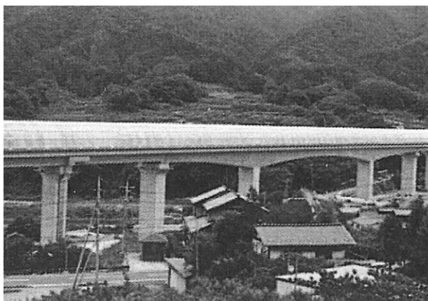
リニア中央新幹線のフード設置例
