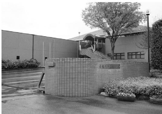
釜無川浄化センター（終末処理場）
