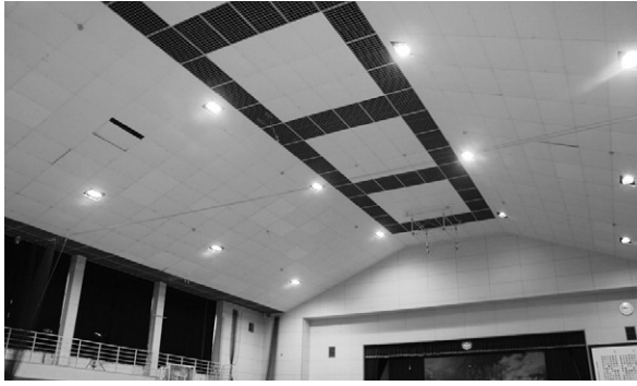
撤去が予定されている 体育館の吊天井
