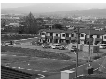
建設中の第2期神明団地
