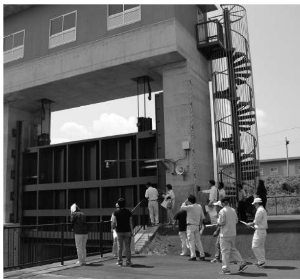
東花輪排水機場視察
