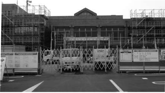
庁舎南館の改修風景
