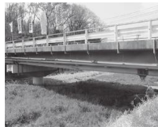
補強工事を終えた新作興橋
