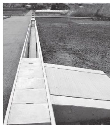
高部地区農業用水路
