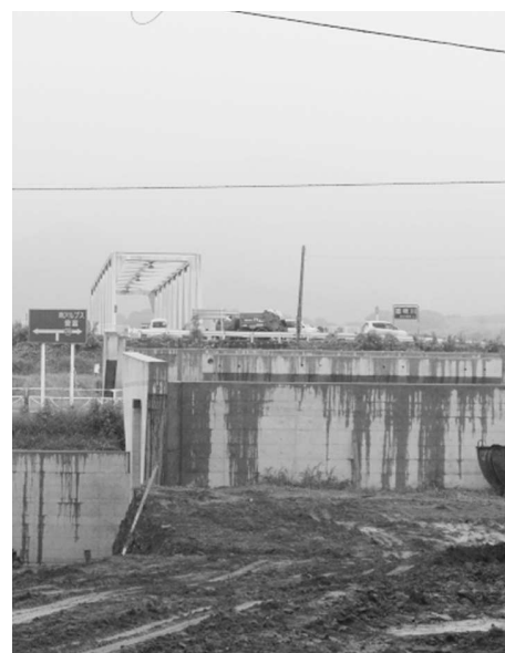
工事中の万年橋
