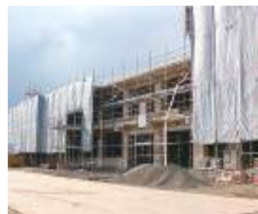
改修中の田富小学校
