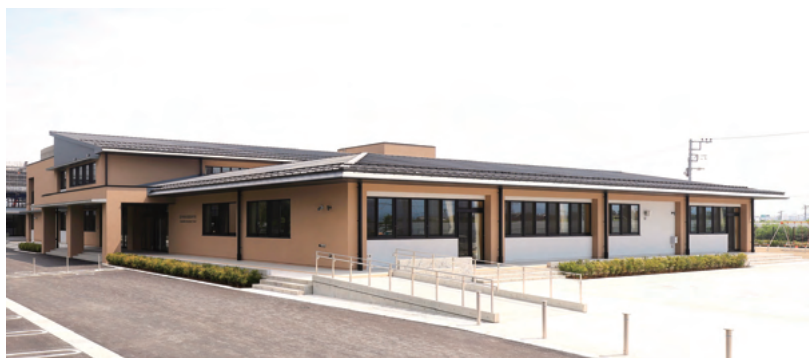
令和5年に新しく竣工された田富北小学校
