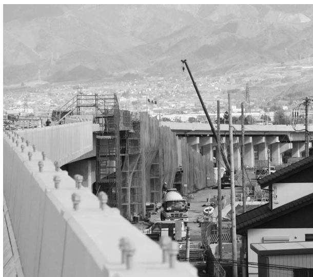
工事中的新山梨環状線
