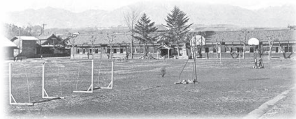
昭和30年頃の木造校舎2号館
