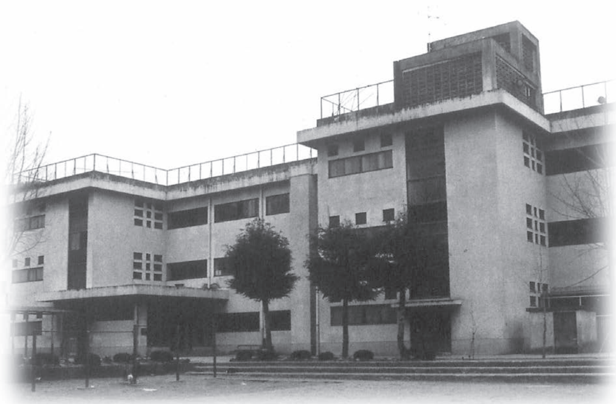
●解体が予定される豊富小学校
